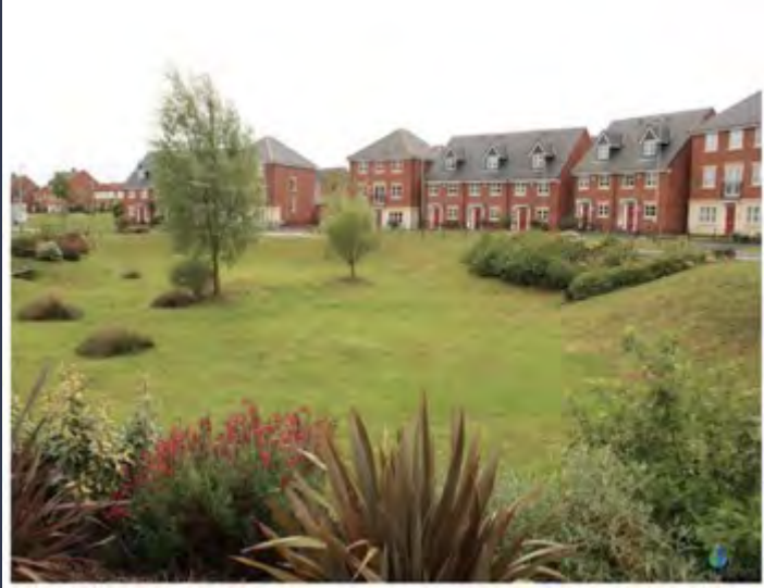
Estanque de infiltración ( Susdrain )
