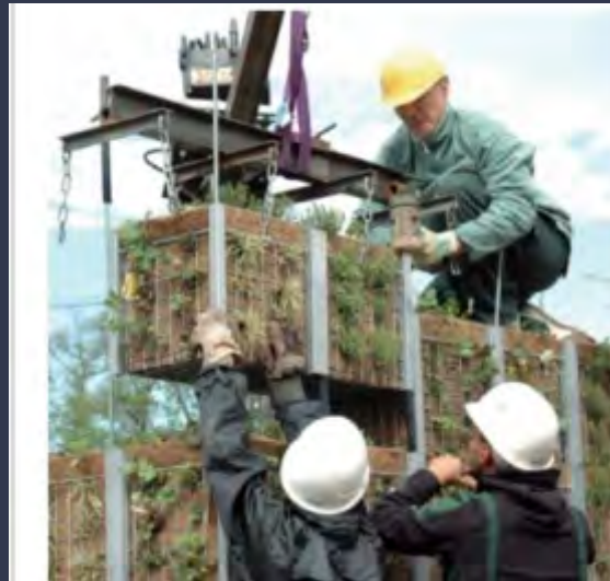
Construcción de una pared autónoma (Helix Pflanzensysteme GmbH)
